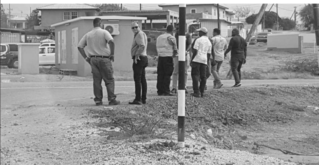
Preparashonnan ta tumando lugá pa konstruí un rotònde na e krusada di Kaya Amsterdam-Kaminda Djabou. E kombinashon di foto ta musta funshonarionan di R&O i kompanianan di utilidat na e sitio ta diskutí tokante tur loke e trabounan lo bai eksigí.
